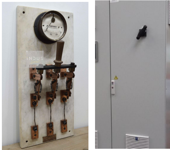
Le sectionneur (HORS CHARGE)
